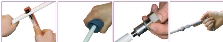
Отрезать трубу при помощи трубореза (артикул 675). Не используйте ножовку. Небольшая деформация конца трубы не мешает процессу установки, но при значительной рекомендуется повторно отрезать трубу так, чтобы конец трубы был без существенных дефектов.
