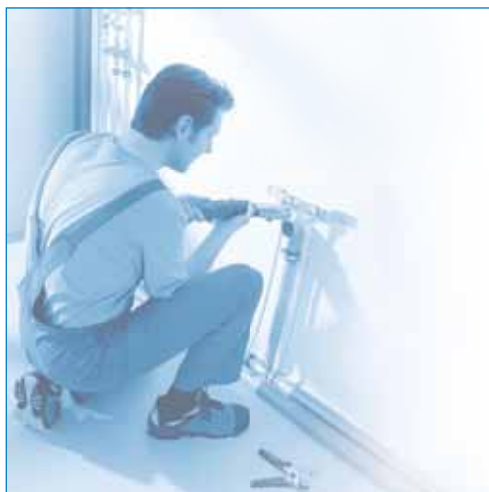
Водоснабжение и радиаторное отопление Uponor MLC
